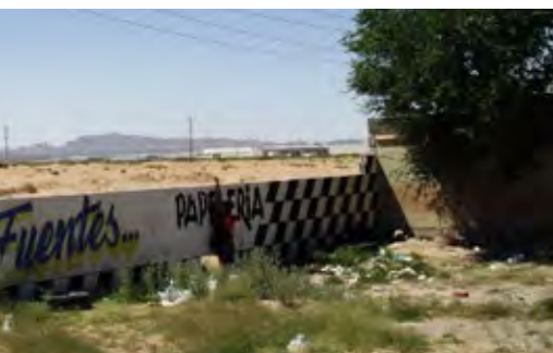
ESTRUCTURA VIAL IRRUMPIDA POR LOS LÍMITES DEL PREDIO DEL CONJUNTO HABITACIONAL
